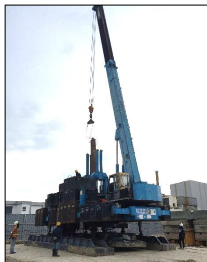
รูปที่ 2-9 การยกเสาเข็มด้วยระบบไฮดรอลิก
