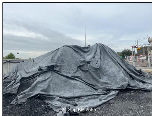
รูปที่ 2-6 ผ้าใบหรือพลาสติกปิดคลุมกองดิน หรือกองเศษวัสดุต่างๆ
